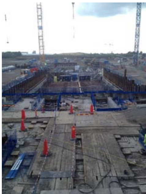
Överblick över arbetsplatsen vid EES.
