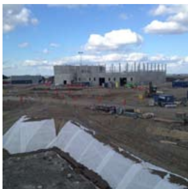
En av de byggnader som uppförs vid EES.
