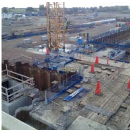
Överblick över arbetsplatsen vid EES.
