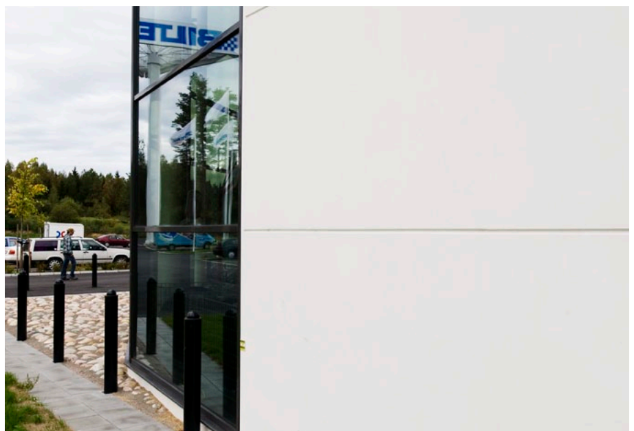
Figur 16. Biltema har valt betongfasader med fotokatalytiska egenskaper.
