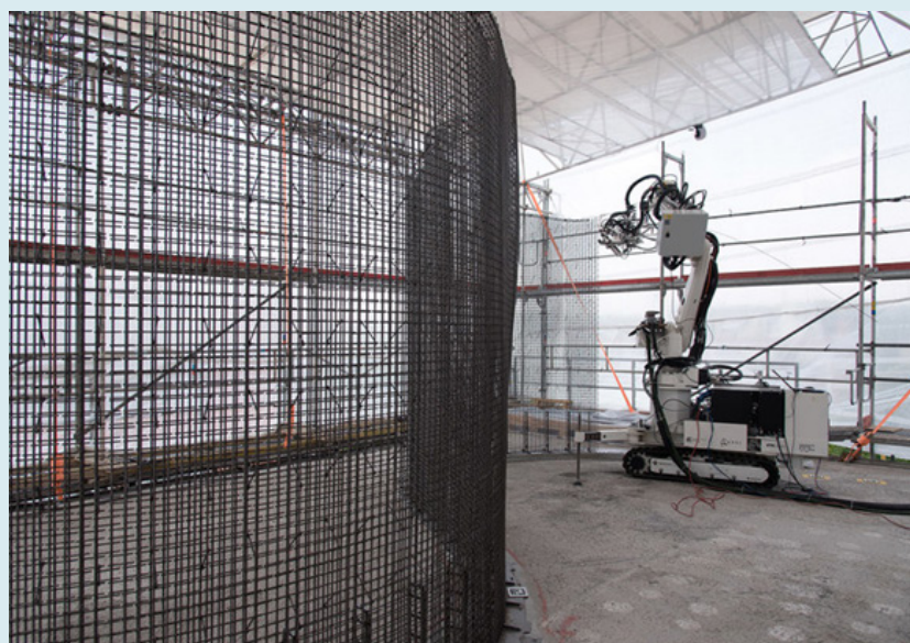
3. Mesh Mold, formfri väggjutning i en robotiserad process. Se YouTube-klipp: https://youtu.be/ZeLEeY8yK2Y
